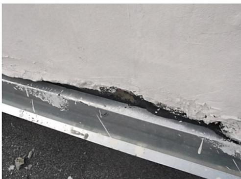
**Примыкание фартука к стене вент.канала не промазано герметикам** - затекание дождевых и талых вод.
