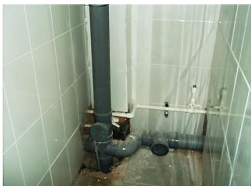
**Отсутствует гидроизоляция в перекрытии** - сложности в эксплуатации системы.
